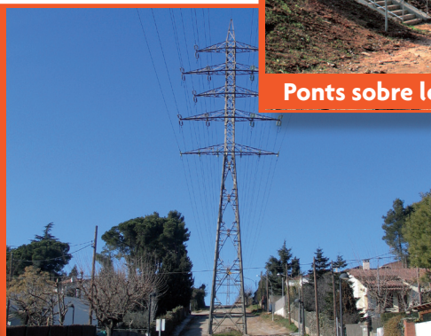
Urbanització de l'avinguda del Baixador.
